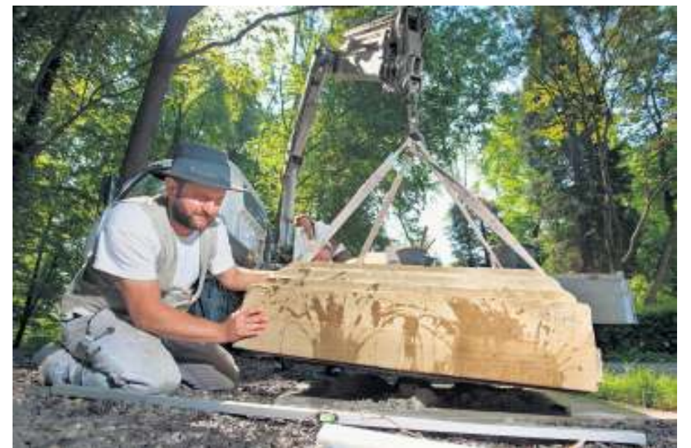
Der Sandsteinsockel senkt sich auf seinen angestammten Platz.
